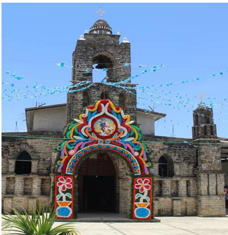
Fig. 4. Capilla de Santiago, Apóstol, Acatitla (Exterior).
